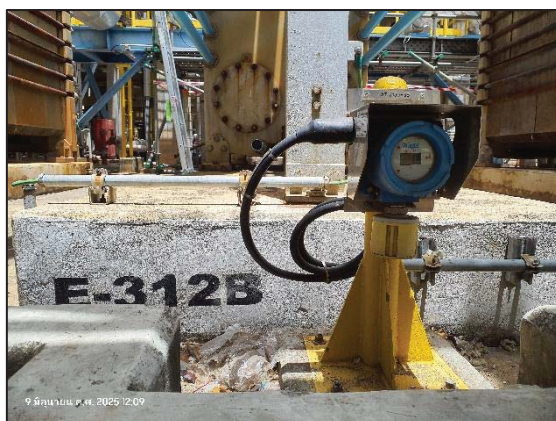
รูปที่ 3.54 Hydrocarbon Gas Detector
