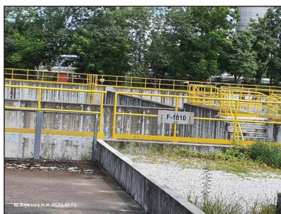
รูปที่ 3.60 บ่อ F-1810 รองรับการรั่วไหลของสารเคมี
