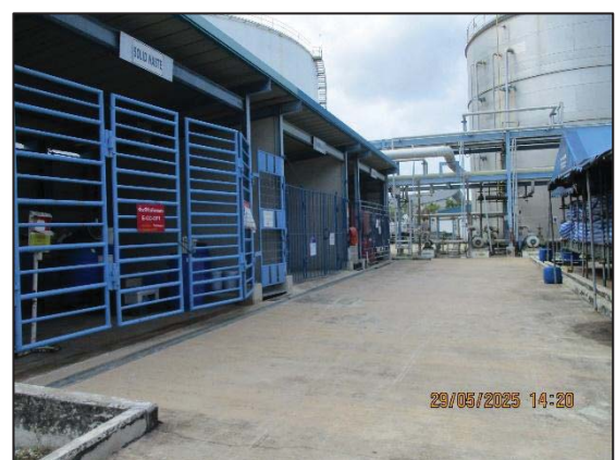
รูปที่ 3.13 พื้นคอนกรีตป้องกันการรั่วซึมของ สารอินทรีย์ระเหย
