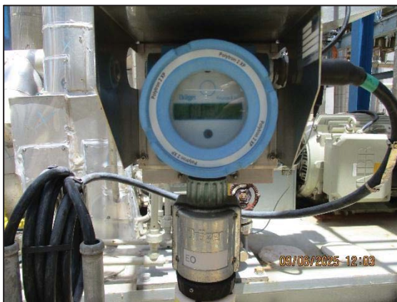
รูปที่ 3.52 Flammable Gas Detector
