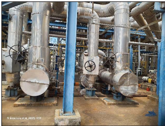
รูปที่ 3.14 Acoustic Insulation (G-624 A/B)
