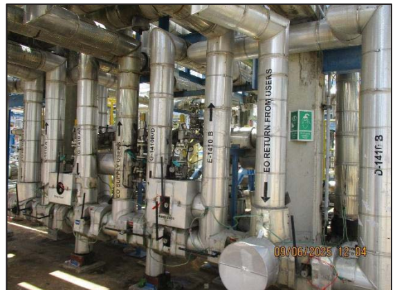
รูปที่ 3.35 อุปกรณ์ที่เกี่ยวข้องกับเอทิลีนออกไซด์ ที่ทำจาก Stainless Steel
