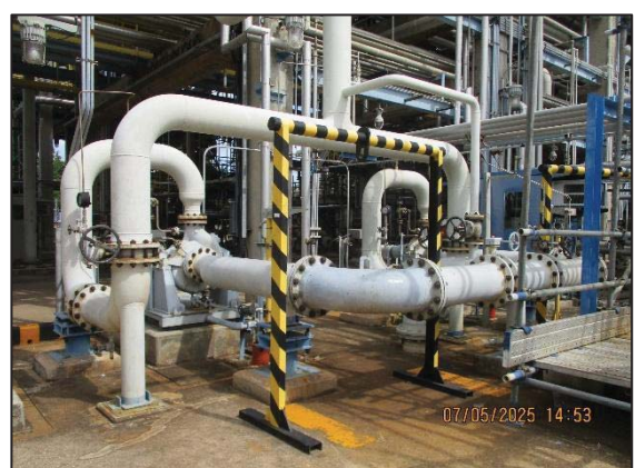
รูปที่ 3.37 Check Valve
